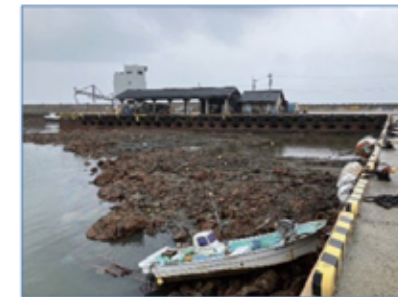
漁港の被害(海底地盤隆起)、 漁船の座礁
