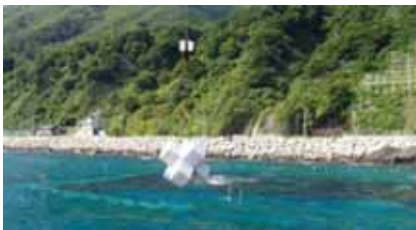
藻場の造成の様子（海藻が着定しやすいブロックの設置状況）
