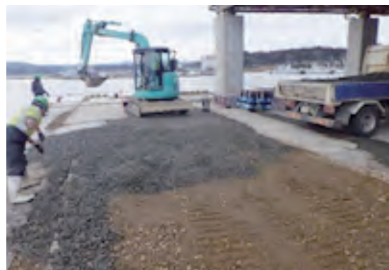
（復旧作業の状況） 砕石ですり付け、岸壁の利用再開
