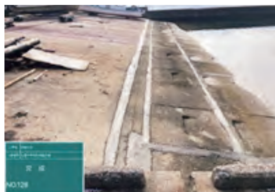
(復旧作業の状況)
