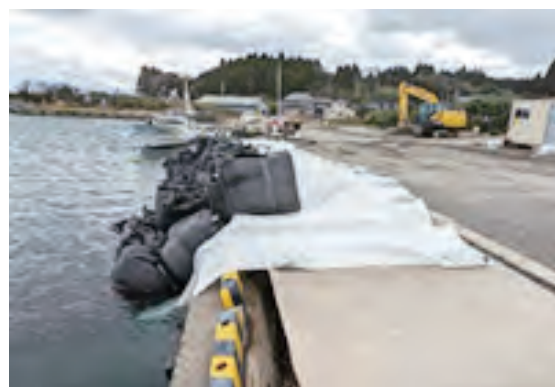
(復旧作業の状況)
