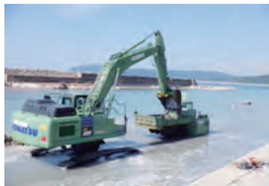
（復旧作業の状況） 泊地の浚渫を行い、利用再開
