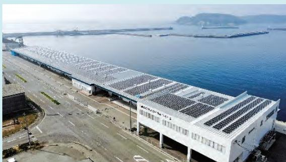
浜田漁港高度衛生管理型7号荷さばき所に設置された太陽光発電設備
