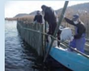
風浪等によるヨシ帯の消失を防ぐため、ヨシ帯前面に木柵等の保護柵を設置する取組[茨城県]
