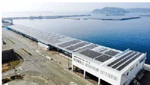
はまだ 浜田漁港高度衛生管理型7号荷さばき所に設置された太陽光発電設備
