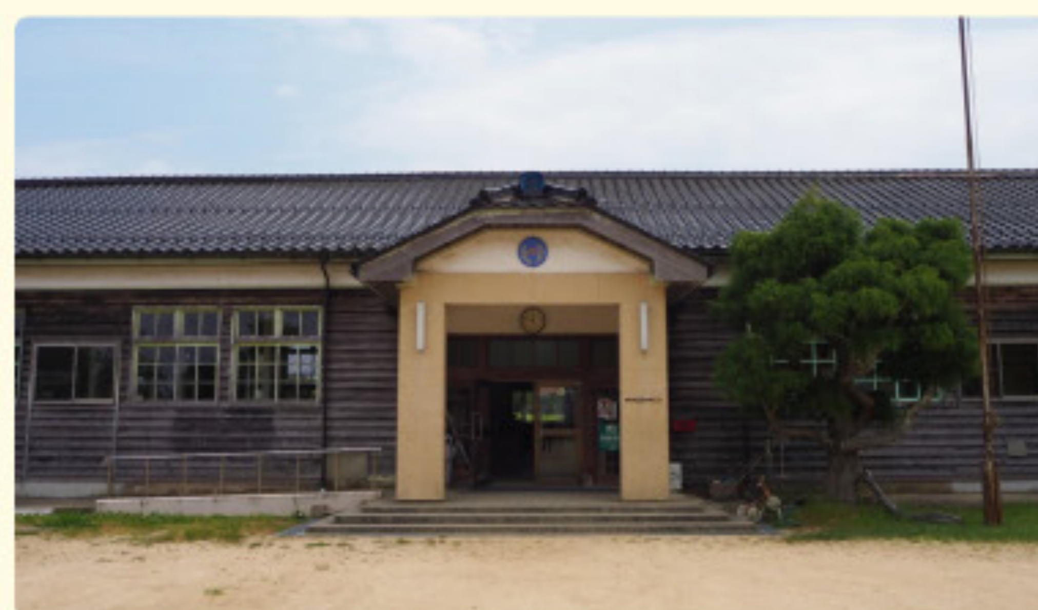
1954（昭和29）年に建て替えられた木造校舎
