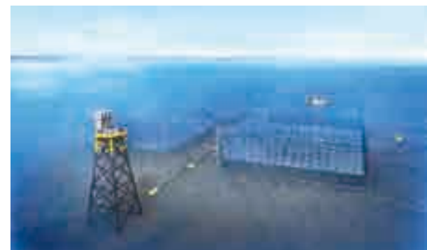
境港沖合3kmの美保湾内に、約300㎡の自動給餌システムを設置。ここに飼料サイロを設置し、生け簀内に設置された給餌タンクへ圧縮空気で飼料を搬送し、給餌。これにより従来の1/3程度に省力化が可能となります
