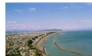
漁港海岸の整備
