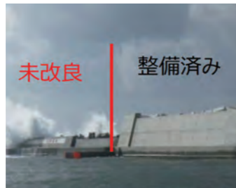
漁港施設の耐震・耐津波化
