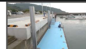
陸揚げの軽劣化に資する 浮体式係船岸の整備
