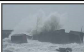
防波堤の嵩上げによる 越波対策
