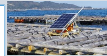
テレメーター設置例
