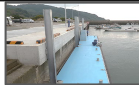
陸揚げの軽労化に資する 浮体式係船岸の整備
