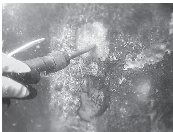
図ー1 鋼材のケレン作業状況
