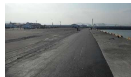
応急復旧の実施
