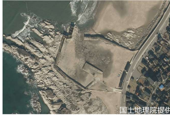
漁港施設（輪島市黒島漁港）
