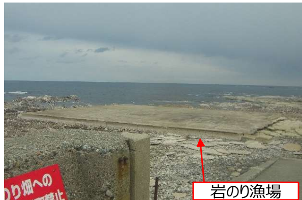
漁業用施設（北部珠洲地区）
