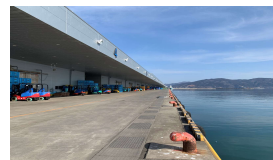
本復旧（原形復旧）の実施
