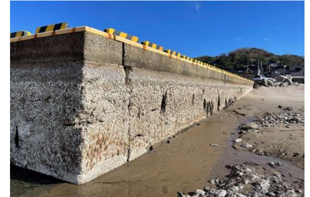
漁港施設（輪島市黒島漁港）
