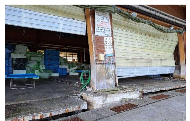
共同利用施設（輪島市輪島港）
