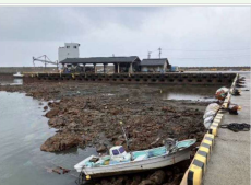
地震に伴い、2～4m程度地盤が隆起。このため、防波堤の基礎がむき出しになり、泊地が干上がっている状況
