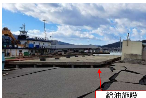
共同利用施設（輪島市輪島港）
