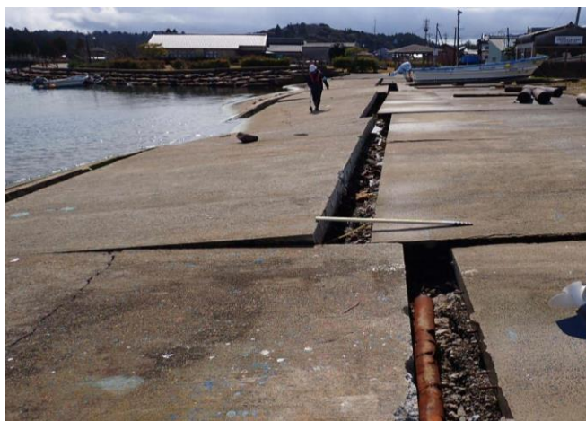
船揚場の沈下・ズレ・開き
