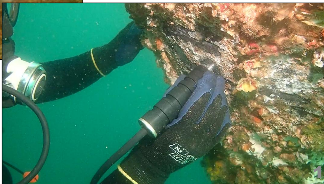
超音波厚さ計による測定状況
