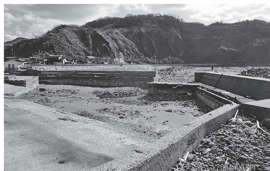
図-2 地盤の隆起による泊地の海底露出(深見漁港)
