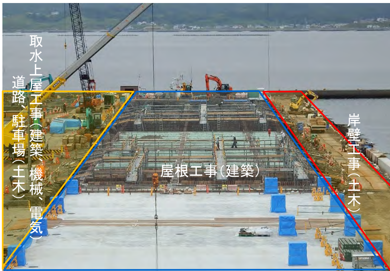
工事の輻輳状況
