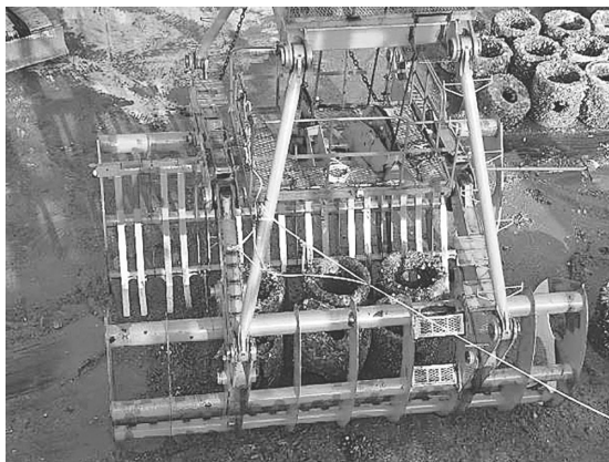
写真-3 バケットによる積み込み作業
