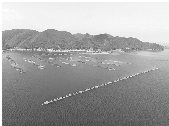
写真-9 整備完了状況
