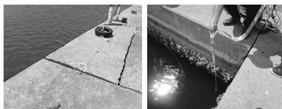
写真-6 スケール(巻き尺)の垂下状況および補助ロープの設置状況(1m間隔)
