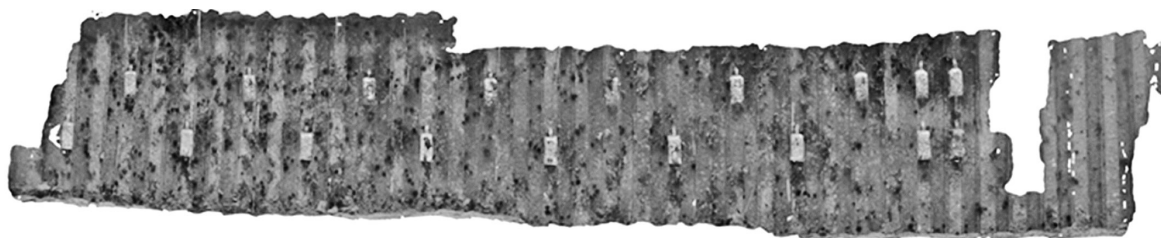
写真-12 矢板式係船岸の平面画像
