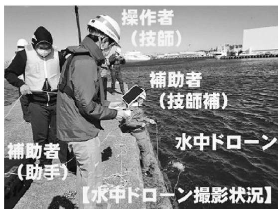
写真－7 水中ドローンによる撮影状況
