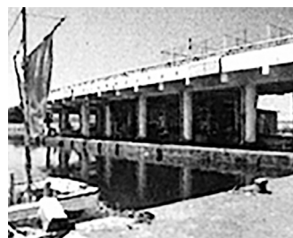
写真-5 旧漁協荷捌施設
