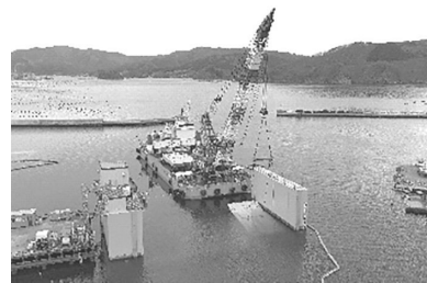
扉体現地据付
