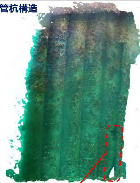
開孔部の状況
