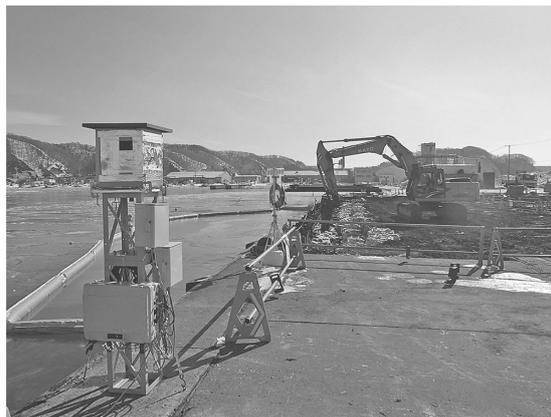
写真-8 前面矢板法線変位のモニタリング状況
