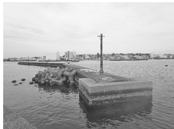
図-2 全景(起点→終点方向)
