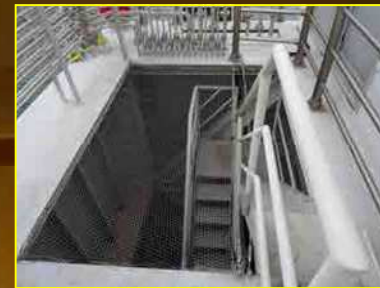
① 函体管理塔天端 ダイバー通用口
