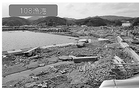
図－２－３ 漁港施設の倒壊・損壊
