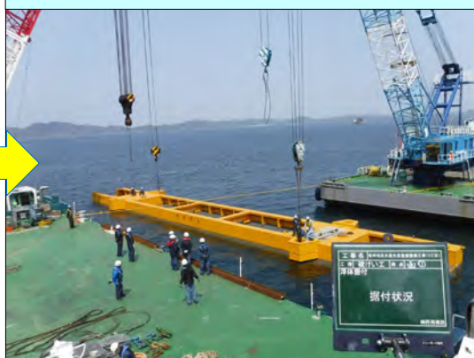
⑥浮体据付
