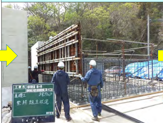
④型枠設置
