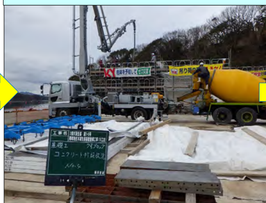
⑤コンクリート打設
