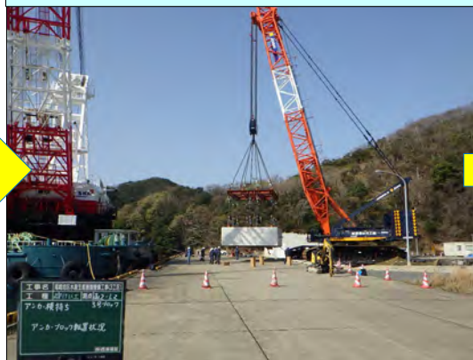
②アンカーブロック横持ち
