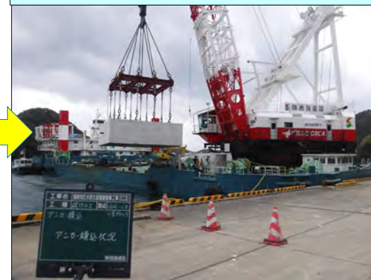
③アンカーブロック積込み
