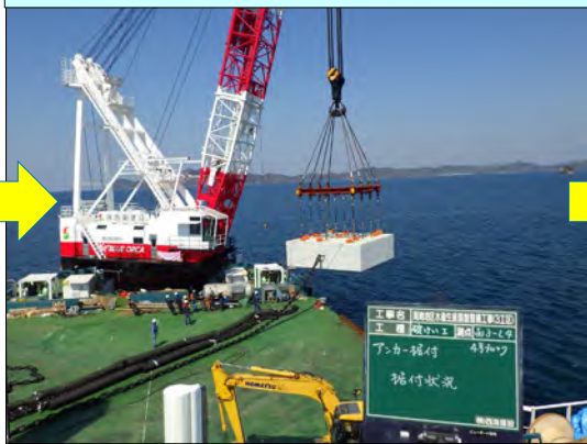
④アンカーブロック据付
