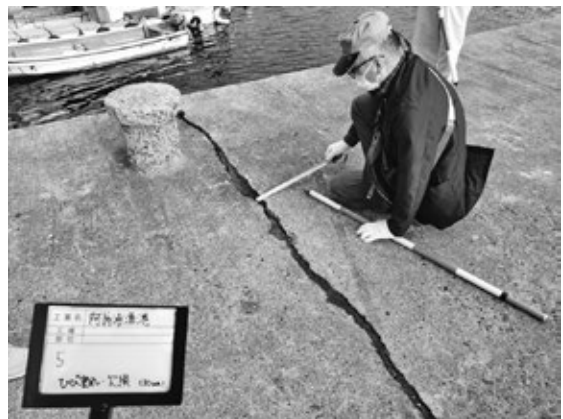
写真二 OB点検状況
