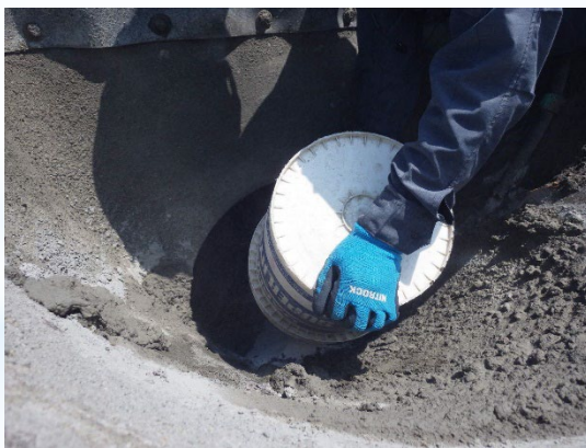
アミノ酸をアジデーター車ドラムへ投入
