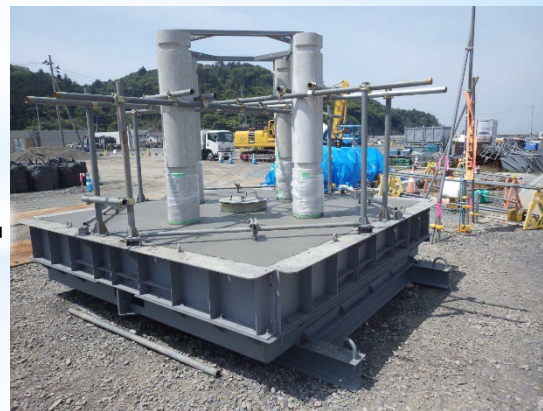
コンクリート打設完了
