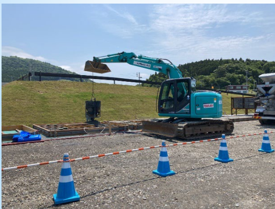
コンクリート打設
