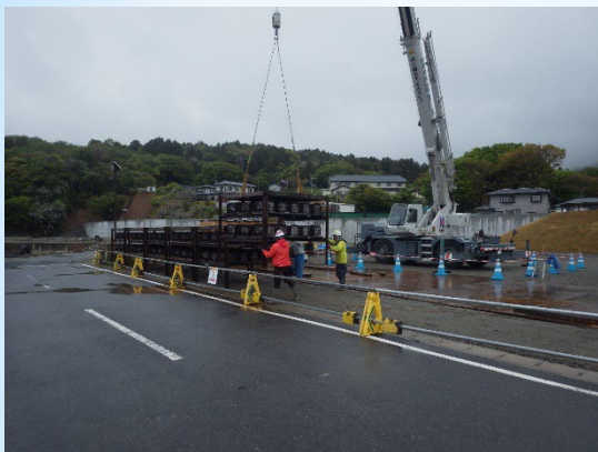
内部ブロック・側枠搬入
