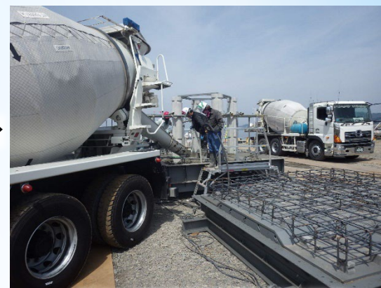
コンクリート打設
