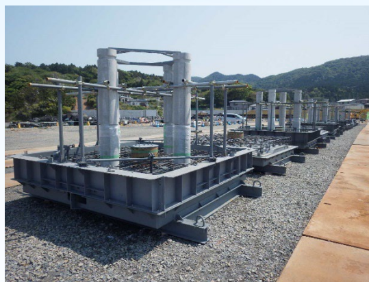
部材組立完了
