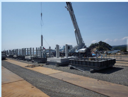
専用型枠に柱をセット
