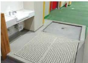
外部から施設に入る際は、手洗いに加え靴底の殺菌・洗浄を行い、施設内の衛生状態を保ちます。
