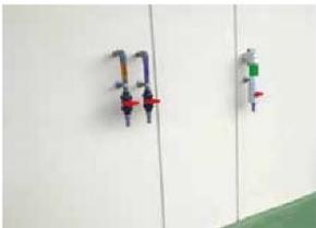
施設各所に紫外線殺菌済みの冷たい海水(5℃)が出るバルブを設け、清潔な海水で魚の処理を行います。
