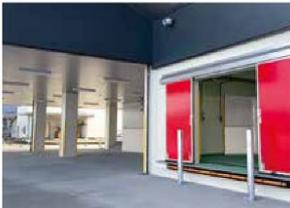
荷捌き施設の搬入口に扉と段差を設け密閉型にすることで、車両や粉塵等の進入を防ぎます。
