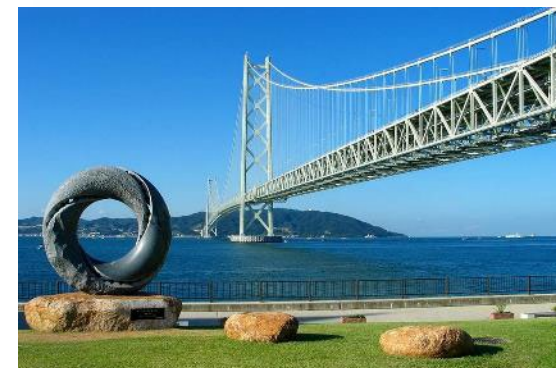
● 明石海峡大橋
