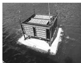
写真-8 3) 据付状況
