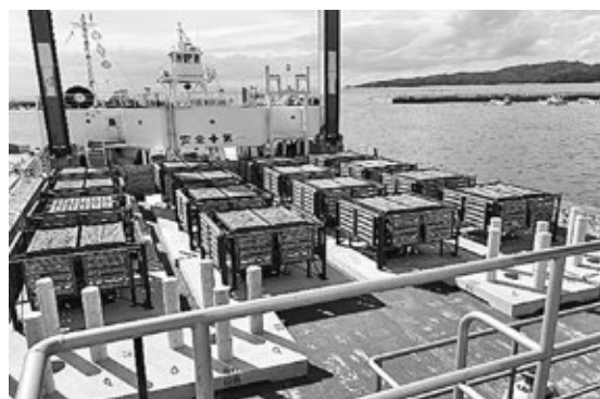
写真-6 3) 起重機船積荷状況
