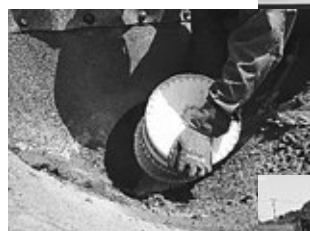
写真-4 3) コンクリート打設状況
