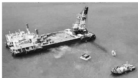
写真-7 3) 当社所有船舶「第73幸丸 210 t 吊」 による据付状況
