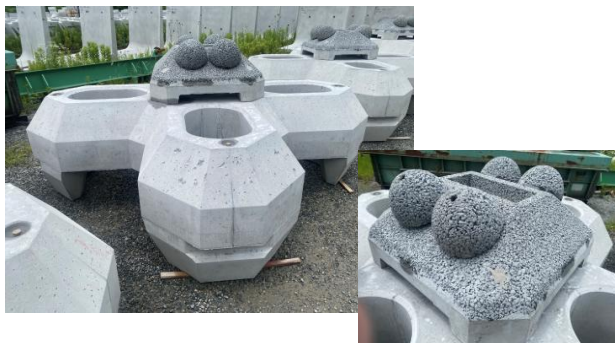
着脱基質を有する新規藻場造成構造物
