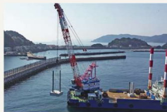
基盤ブロックの設置状況
