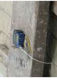
道路改良工事 (RTR-52A)
