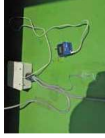
橋梁点検業務 (ひずみ計測:0~5V)
