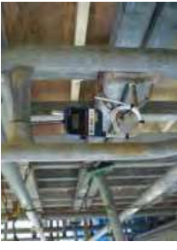
ボックスカルバート工事 (RTR-52A)
