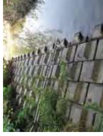
築堤工事 (水位計測:4~20mA)
