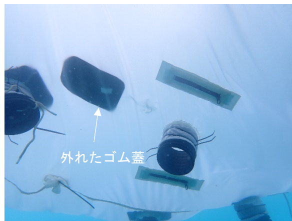
図-I.2.8 幼生流出防止用のゴム蓋が外れた状況
