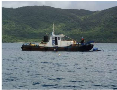
作業船による架台の設置
