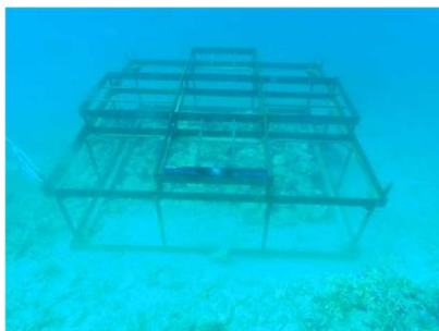
サンゴ着生・育成基盤(凸凹型) 施工状況(4/11)
