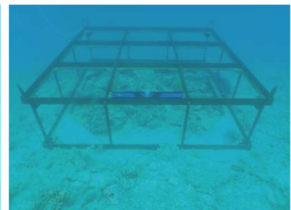
サンゴ着生・育成基盤(平型) 施工状況(4/12)
