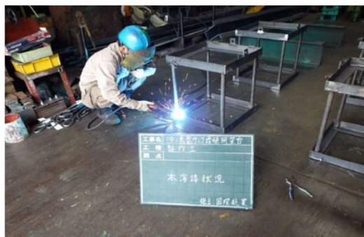
基盤製作状況
