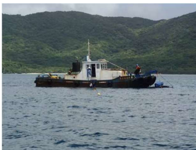
作業船による架台の設置
