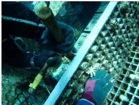
移植サンゴの取外し
