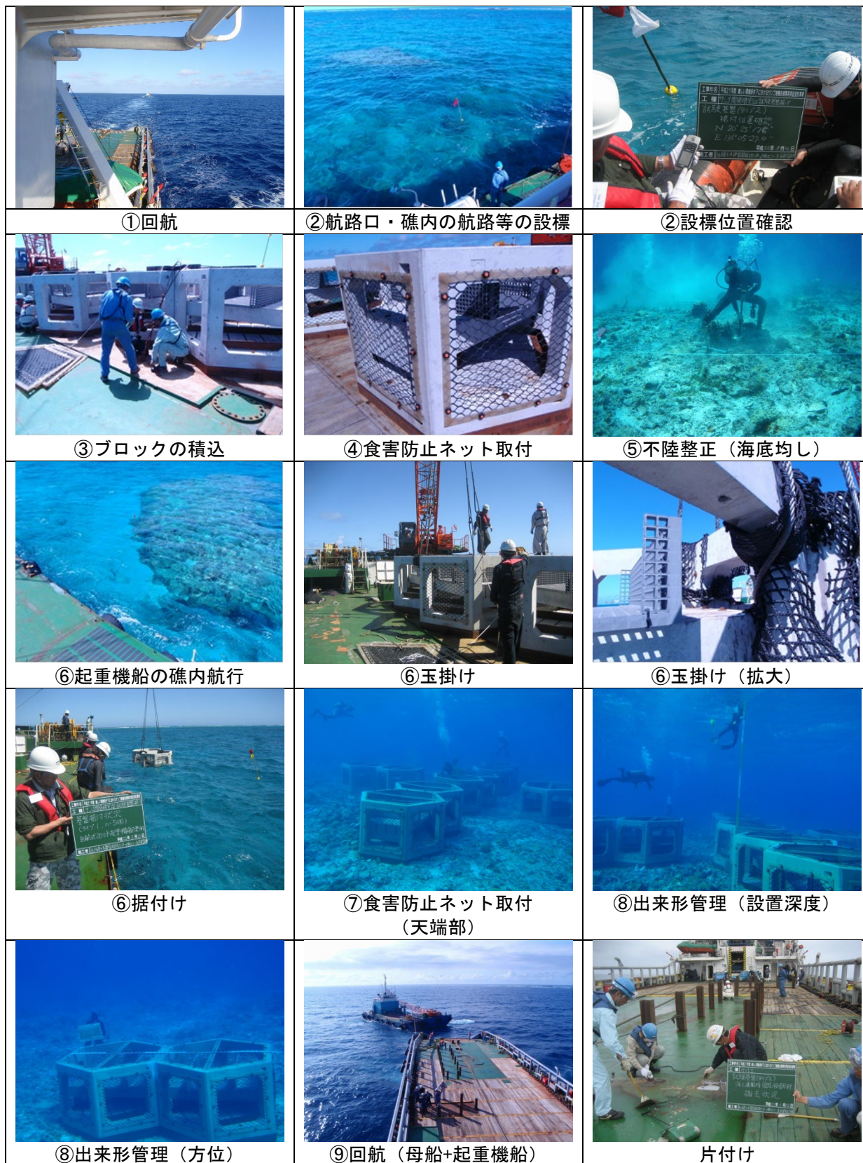
図Ⅱ. 2-15 沖ノ鳥島の間育成施設工事の作業状況
