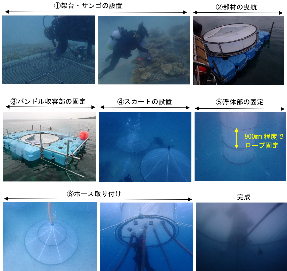
図Ⅱ.4-6 幼生収集装置の設置手順
