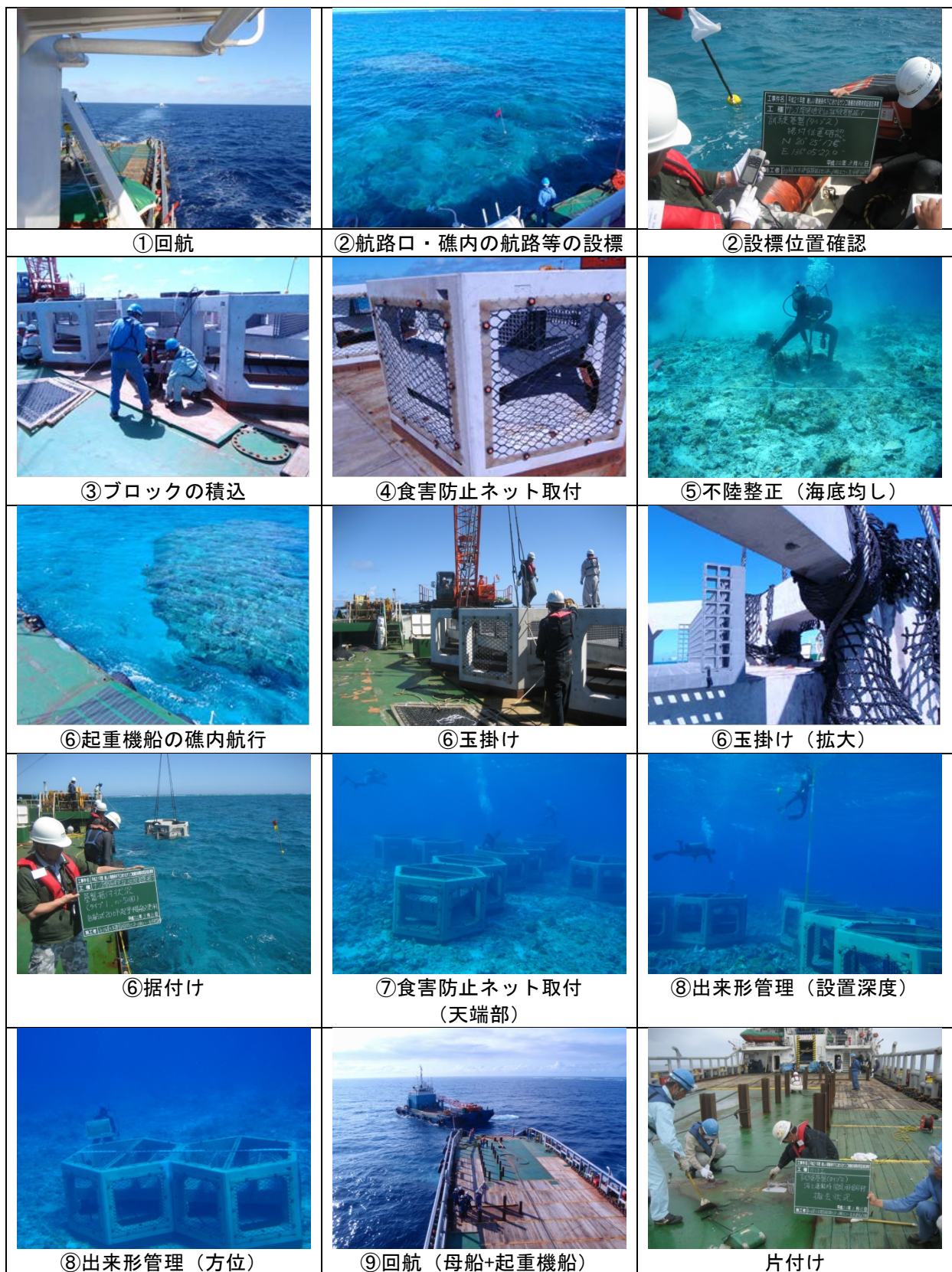
図Ⅱ.2-39 沖ノ鳥島の中間育成施設工事の作業状況
