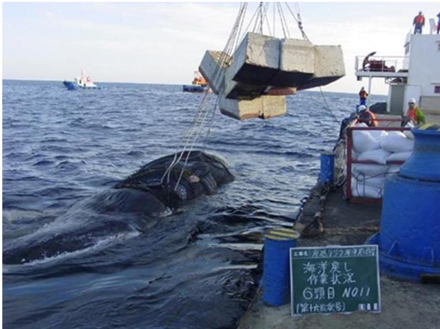
写V-7 連結後、方塊を吊り鯨体と共に海底に沈下
