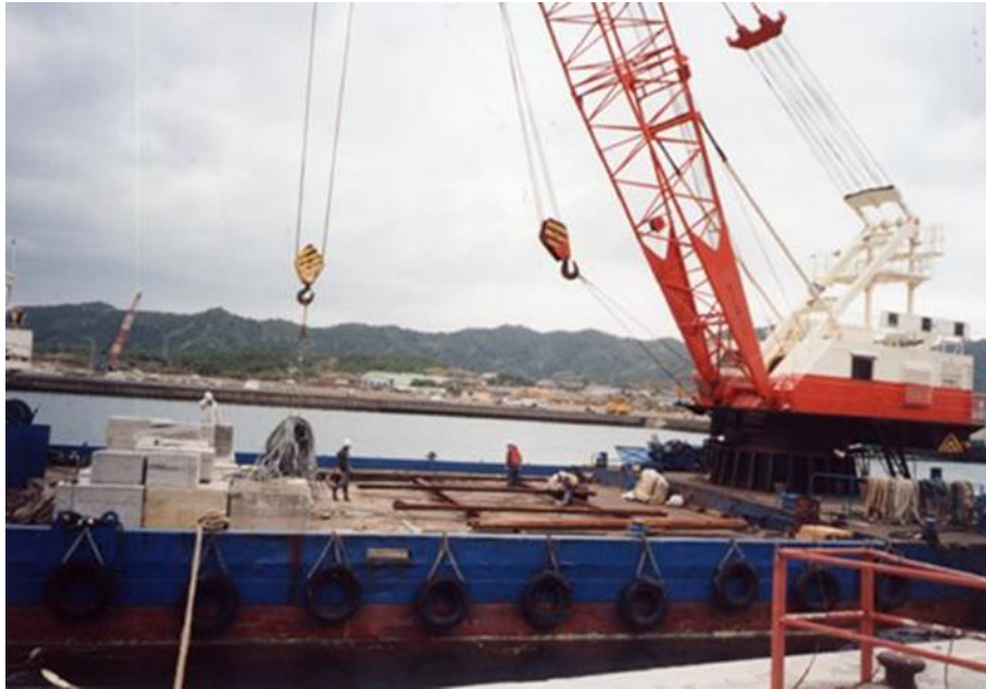
写V-8 漁港に台船を係留。方塊ワイヤー等の積み込み
