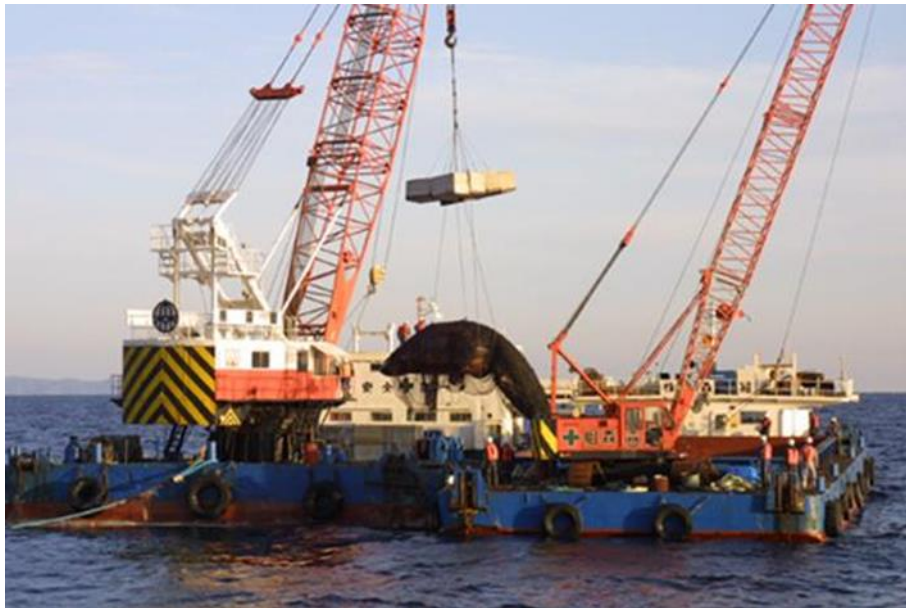
写V-15 方塊と鯨体を合わせた重量が作業船の能力より小さい場合の海底沈下作業
