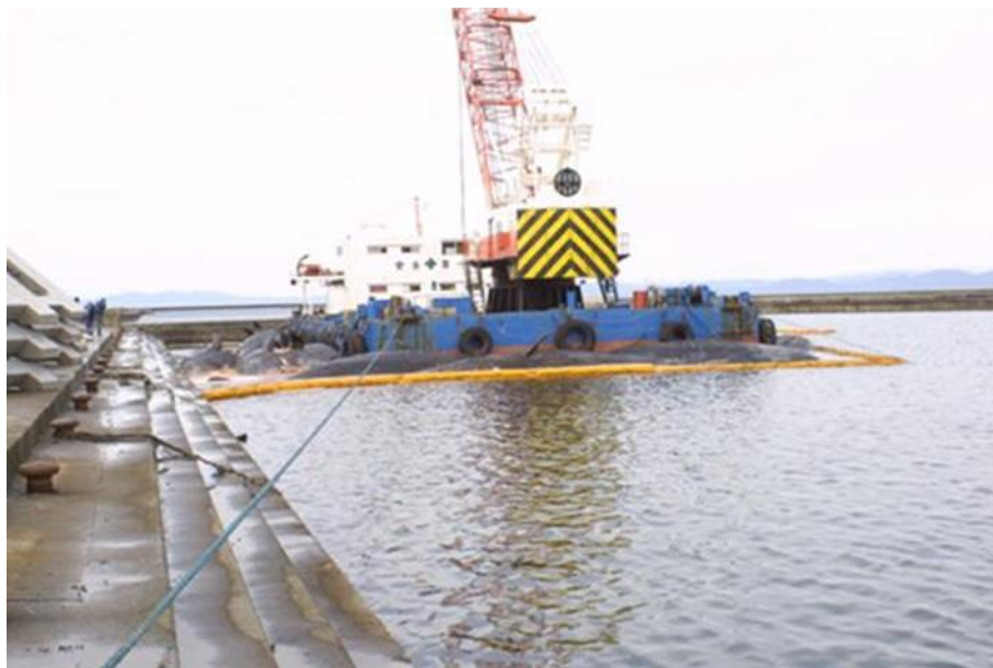
写V-10 オイルフェンスの設置
