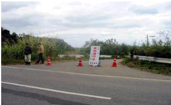
写Ⅱ-5 現場周辺での交通整理
