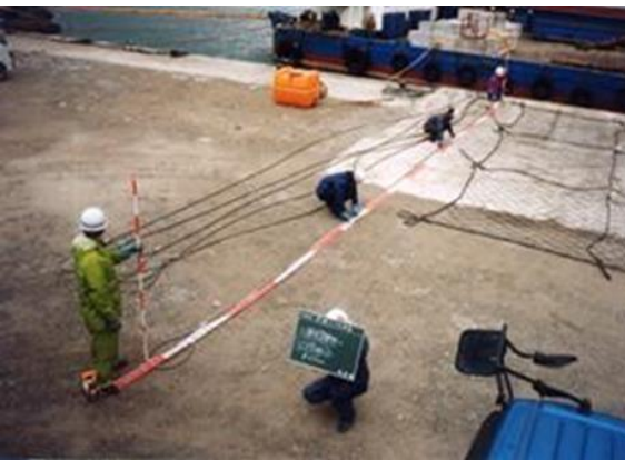
No.4[ワイヤー(鯨吊用)組み立て状況]
