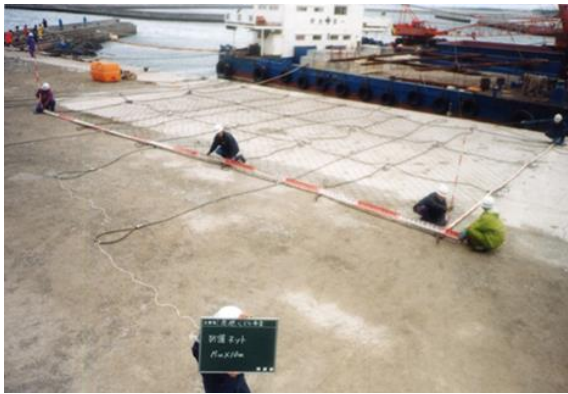
No.1[ワイヤー（鯨吊用）組み立て状況]
