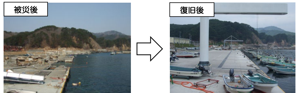
岸壁の復旧状況（岩手県音部漁港）
