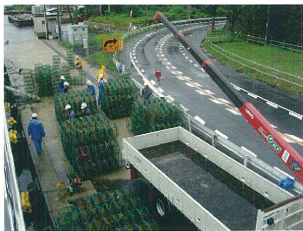
押収漁具の陸揚げ作業
